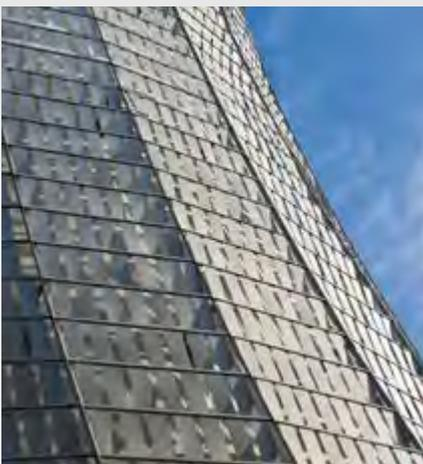
El quebravista WindScreen está compuesto por láminas de aluminio que pivotean sobre un portapanel. Las láminas forman una superficie que se mueve con el viento. Esta cualidad entrega una fachada kinética siempre cambiante y visualmente muy atractiva.
