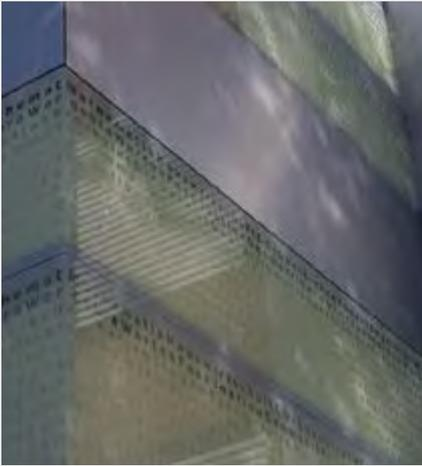
El QuadroGlass es una fachada de vidrio ventilada, formada por paneles compuestos por un fleje de aluzinc perforado encapsulado entre dos cristales de vidrio o también existe la opción de utilizar sólo cristales serigrafiados. Los paneles dejan una cantería de 10 mm entre paneles de vidrio o también cuando se intercalan con paneles metálicos (QuadroClad).
