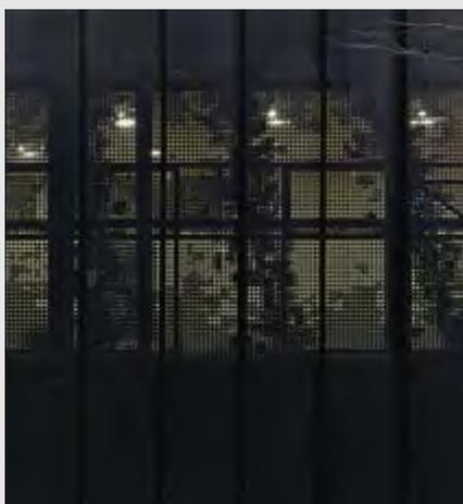
Los paneles de fachadas y cubiertas SL de Hunter Douglas poseen una lectura sencilla, muy similar a la de un panel embaldetado, ofreciendo la posibilidad de proyectar con diferentes anchos de panel (430, 455, 500 y 530 mm).
