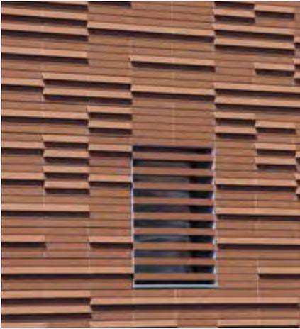
El Baguette es un elemento hueco de cerámica con una sección cuadrada o rectangular. Este producto versátil se utiliza principalmente en ventanas o para el diseño de fachadas ventiladas. En el ámbito de la protección solar, el baguette ofrece protección ideal en combinación con el revestimiento Terrart. Es fácil de instalar, con soportes laterales o sujetadores traseros.
