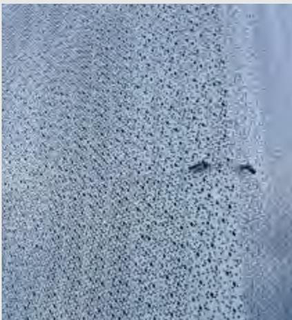
ScreenPanel es un producto de una sola piel que permite revestir fachadas. Se puede instalar en forma vertical u horizontal. Este producto tiene la particularidad de poder ser perforado o con corte láser (tecnología de control numérico de acuerdo a diseños de figuras) o perforados random que el propio cliente puede crear, lo que proporciona una excelente flexibilidad al producto.
