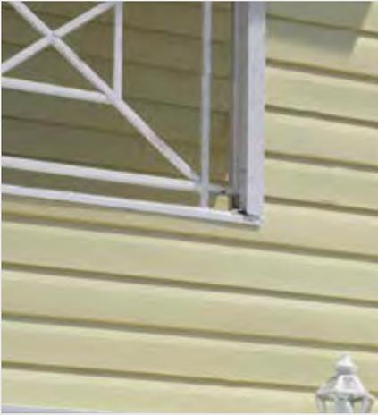
El panel SideWall es un revestimiento exterior y/o interior, que permite construir edificaciones aptas para diversos usos, o remodelar viejas construcciones con un atractivo aspecto, similar a madera tinglada. Otorga además al sistema una gran rigidez estructural.
