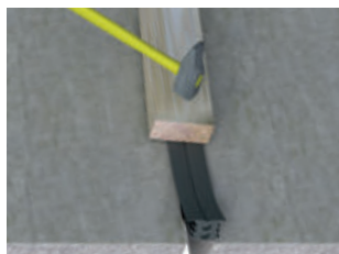
O perfil é então prensado na junta com a ajuda de um revestimento de madeira.
